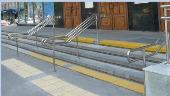
**Указать необходимость установки поручней на лестнице с двух сторон. Без поручней на входной лестнице объект недоступен для опорников и слепых (или условно доступен, но с кнопкой вызова).**
