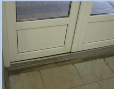
Измеряется вертикальная часть порога. Высокие пороги непреодолимы для колясочников. Доступность при пороге более 2,5 см условная.
