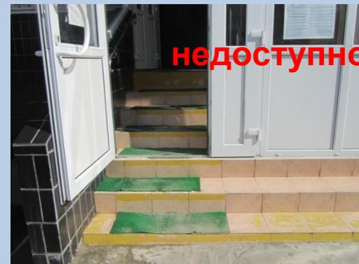
СП 118.13330 6.5 Входная площадка перед наружной дверью должна быть не менее 1,5 ширины открывающегося полотна наружной двери по направлению движения посетителей. На ней должен быть уклон 0,1–0,2 % от здания для стока дождевой воды.
