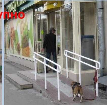
Распространенная ошибка: при установке пандуса не выполняется расширение входной площадки для безопасного маневрирования на кресле-коляске при открывании двери.
