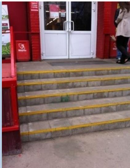
СП 59.13330 п. 5.2.31 Возможно применение для ориентации и помощи слепым и слабовидящим защитного углового профиля на каждой ступени по ширине марша. Материал должен быть шириной 0,05 - 0,065 м на проступи и 0,03 - 0,055 м на подступенке. Он должен визуально контрастировать с остальной поверхностью ступени.
