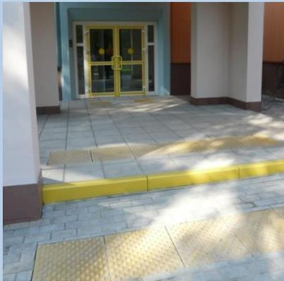
СП 59.13330 5.2.13. При перепаде высот пола на путях движения 0,2 м и менее допускается увеличивать уклон пандуса до 1:10 (10%).
